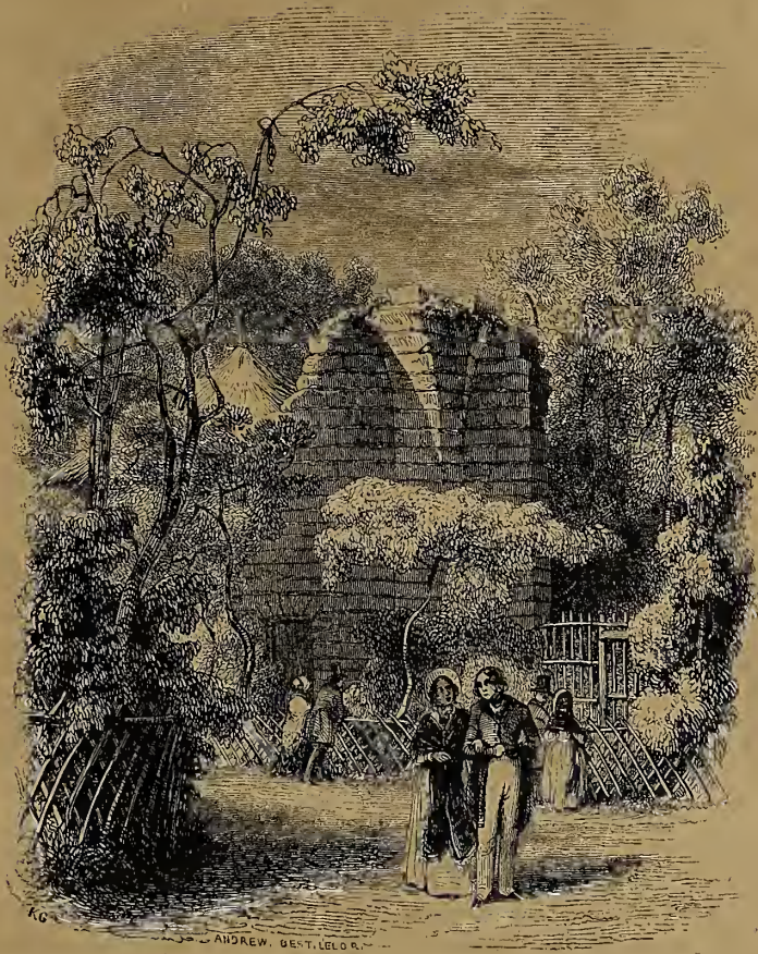
ASPECT DES RUINES DERRIÈRE LA CABANE DES AXIS.
